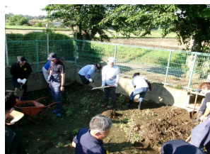
雨水浸透槽の泥かき
